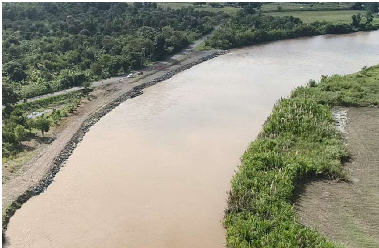
El trabajo de ingeniería mejoró la movilidad de la zona
