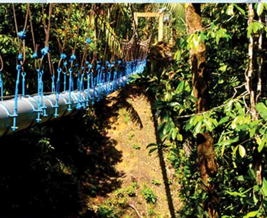
Viaducto de conducción de agua
