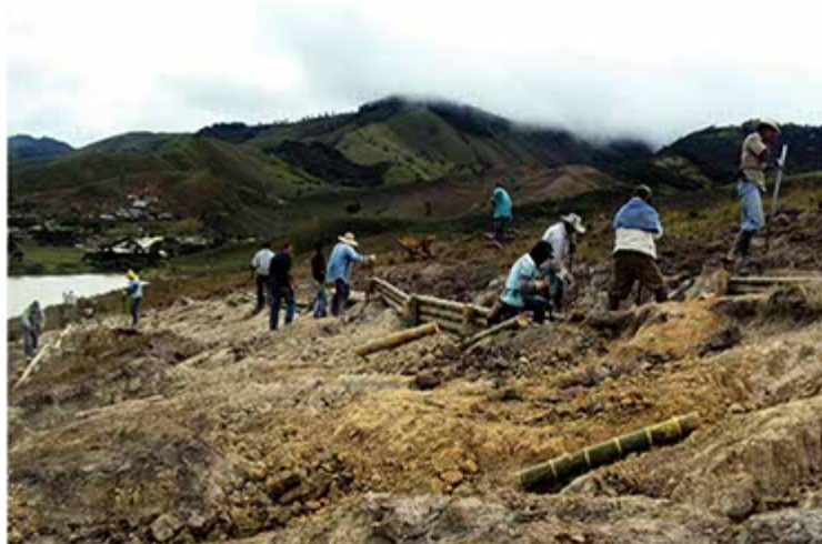
Conformación de trinchos
