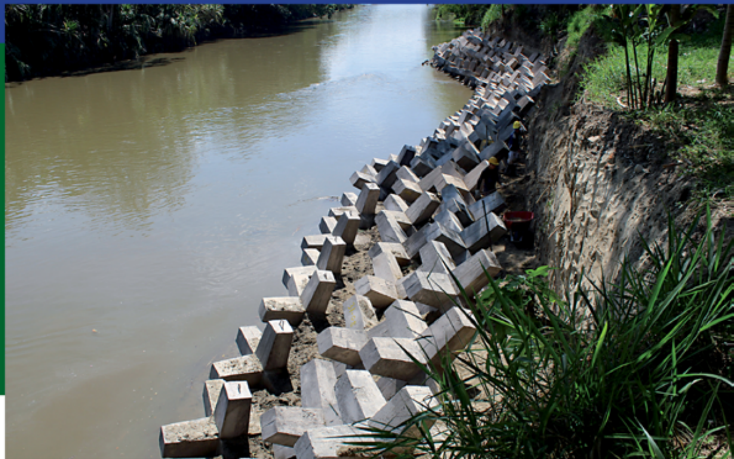
130 hexápodos de dos toneladas evitarán que el río rompa el dique
