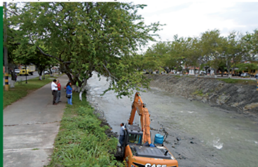
Máquina trabajando en ampliación de las márgenes
